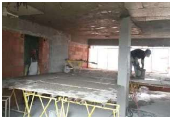
Imagem 2- Aplicação de argamassa em tetos
