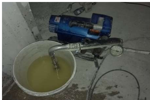
Imagem 5 - Compressor para aplicação do vialfloor fluorsilicato
