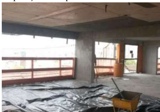
Imagem 1 - Aplicação de chapisco rolado em estruturas de concreto
