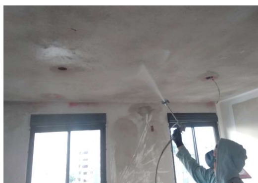
Imagem 6 - Aplicação do vialfloor fluorsilicato em tetos
