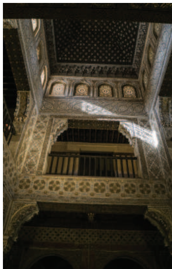
Figura 40. Ventilación e iluminación en los baños.
