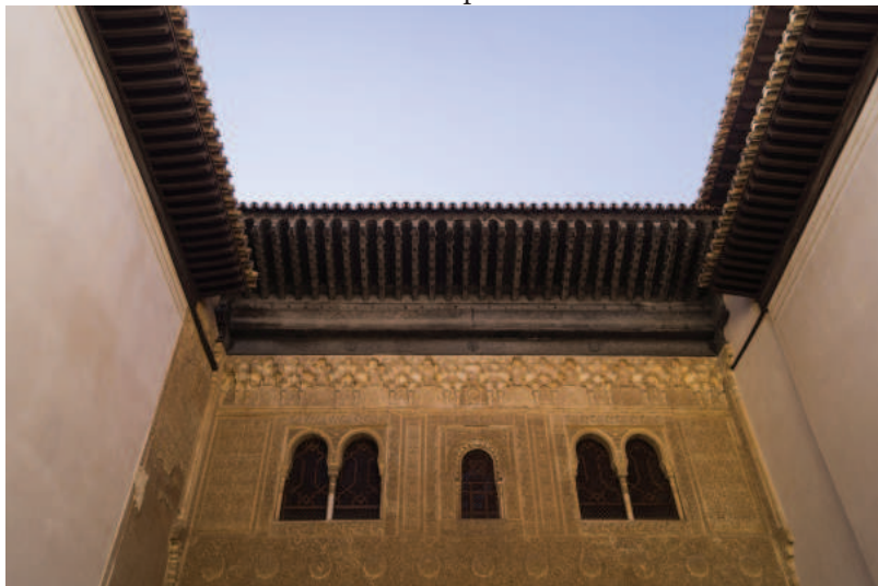
Figura 47. Alero invertido de la fachada de Comares en el patio de Mexuar.
