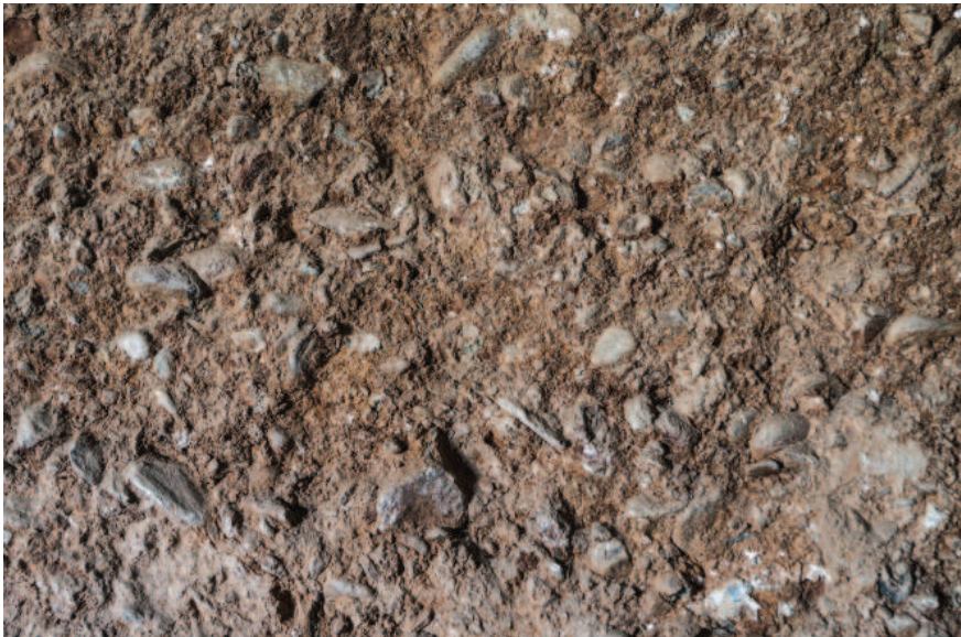
Figura 43. Tierra arcillosa, material de construcción de los palacios.
