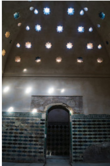
Figura 38. Lucernas de colores en el interior del baño.
