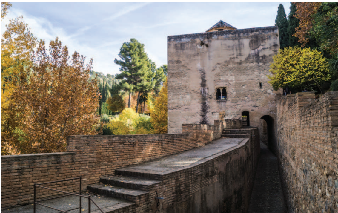
Figura 27. Camino de Ronda y Adarve.
