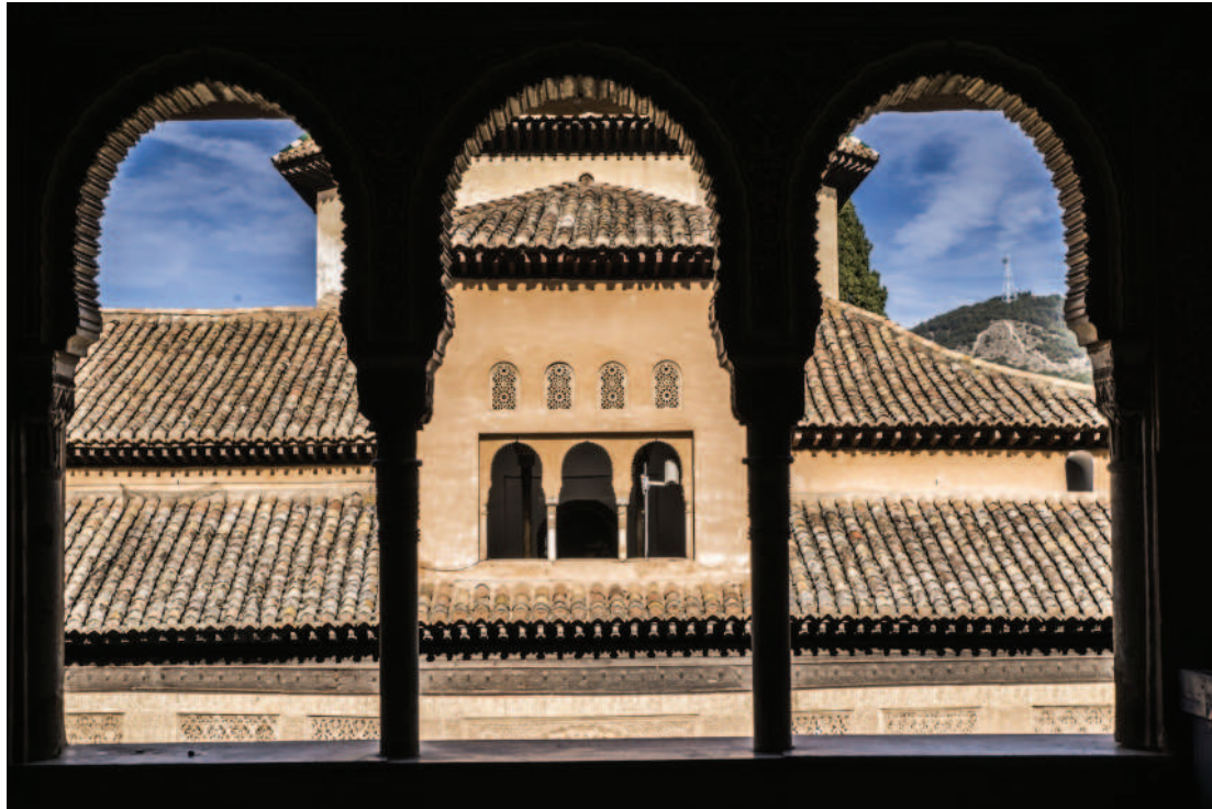
Figura 37. Aberturas, vista desde planta superior, galería sur patio de Los Leones.
