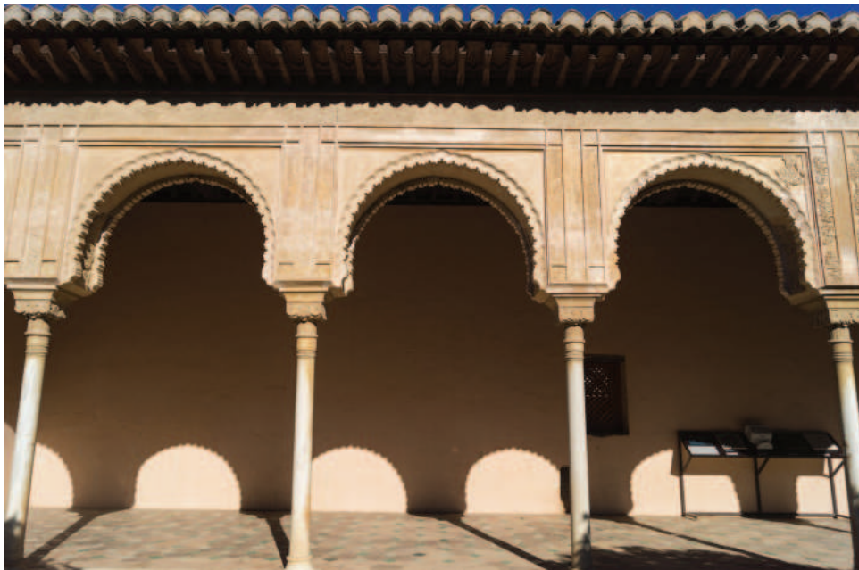
Figura 46. Sala de los Embajadores espesor de muros.
