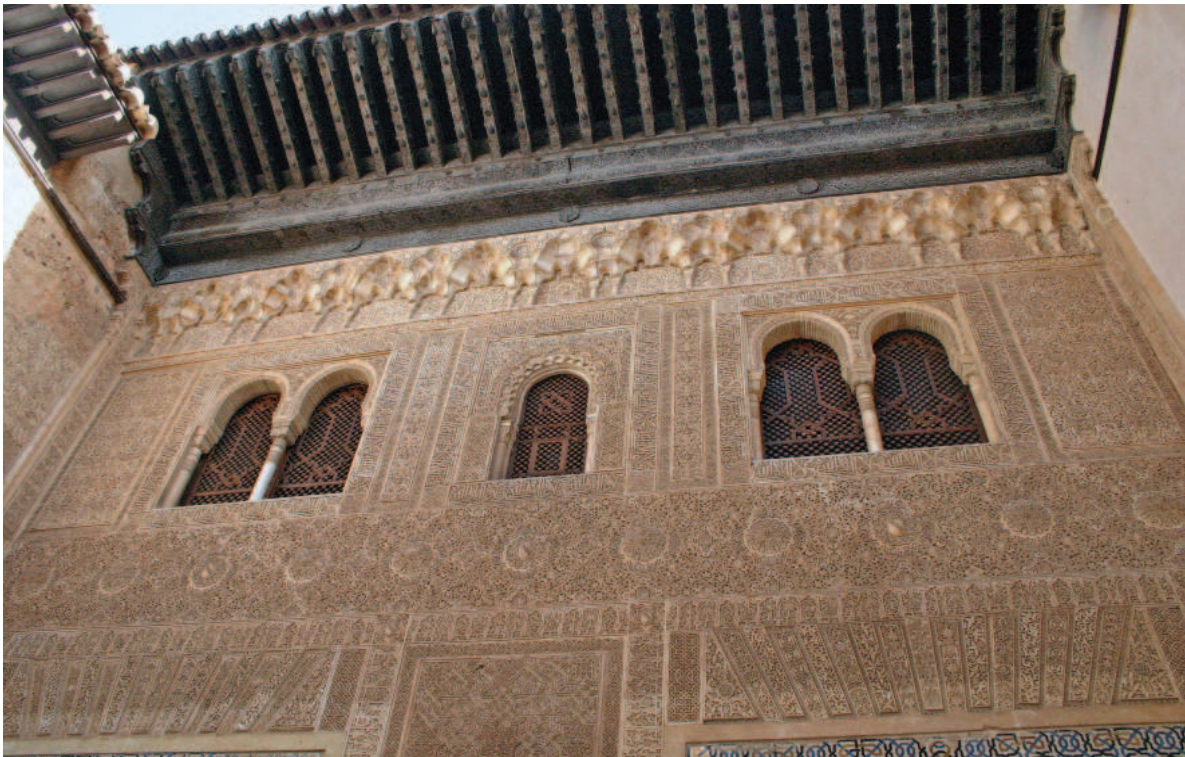
Figura 1. Alero de la fachada del Palacio de Comares.
