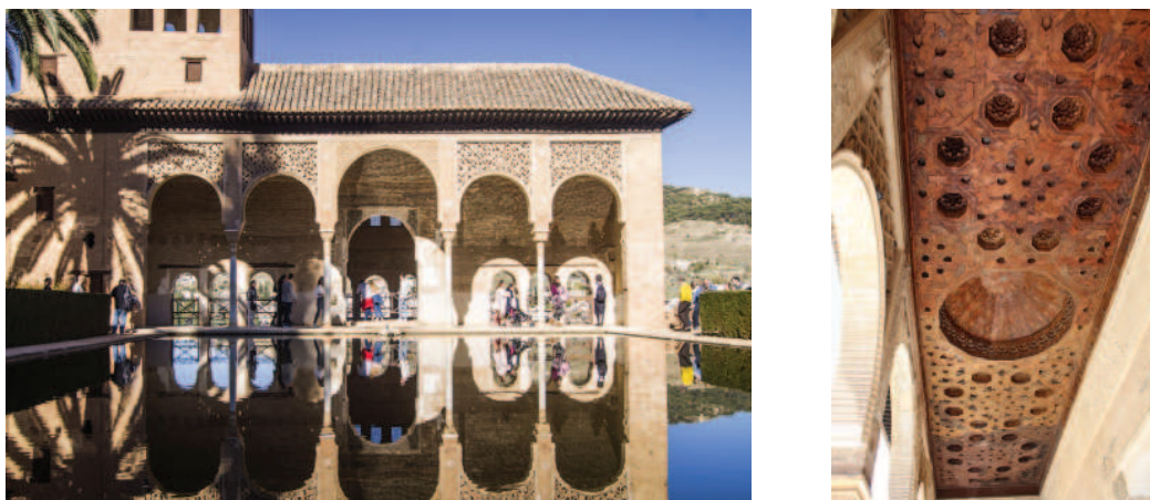
Imagen 25. Palacio del Partal. Fachada y alfarje que cubre el pórtico norte.
