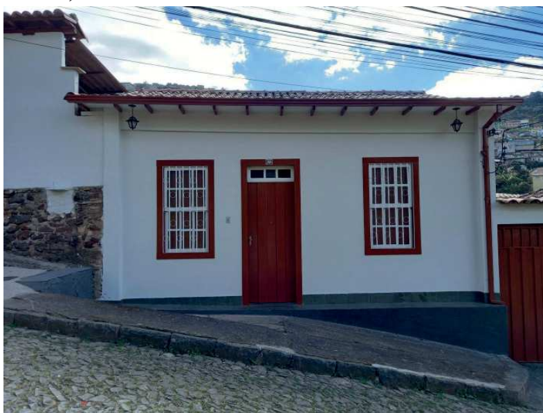
Figura 8. Edificação de construção recente localizada na Rua Padre Faria, no número 249.
