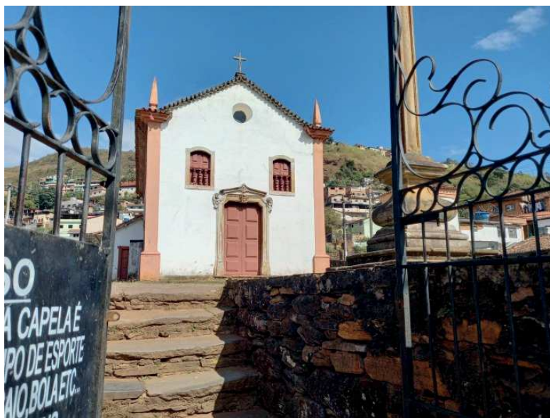
Figura 4. Vista da fachada frontal da Capela do Padre Faria.
