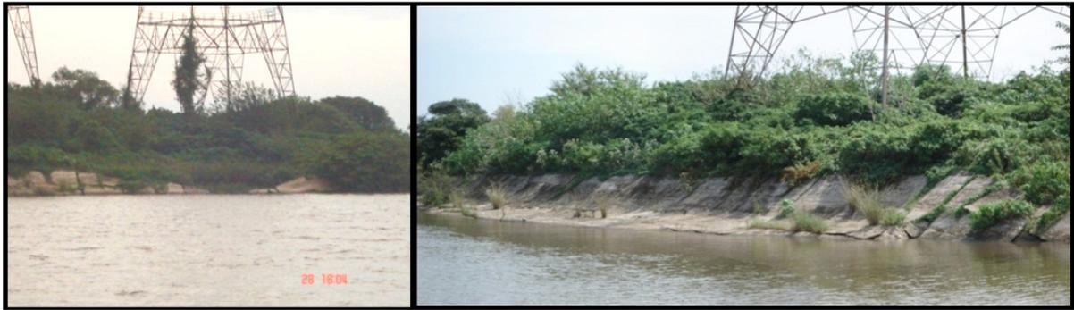
Figura 10. Colchão de argamassa construído na margem montante (erosiva) da barra em canal denominada ilha das Cabras.
