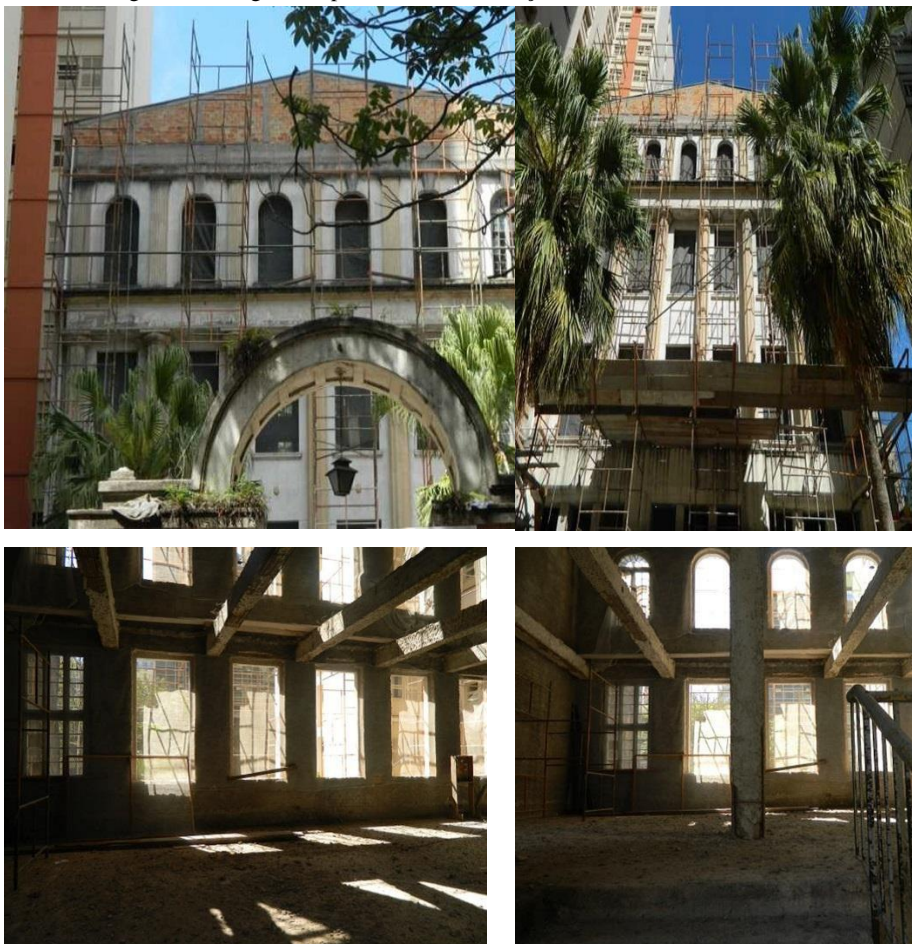
Figura 5 – Imagens do processo de restauração do Ginásio das Dores
