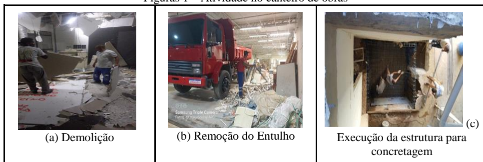
Figuras 1 – Atividade no canteiro de obras
