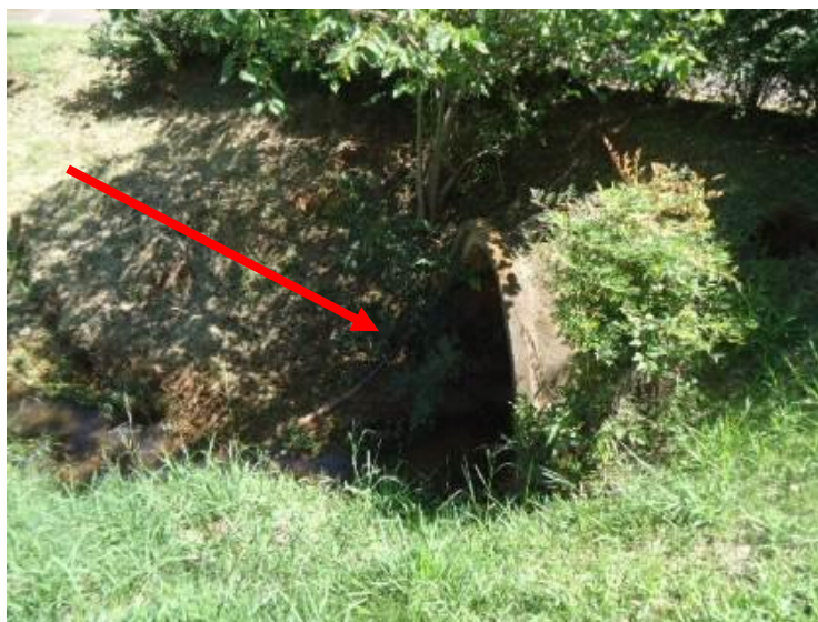
Figura 10. Tubulação a que se referem a figura 9.
