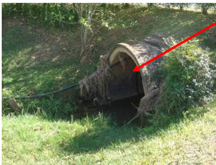
Figura 4. Ponto de passagem subterrânea das águas do córrego Água Fria (perspectiva presente do fundo de vale) sob o leito da Avenida Primavera (perspectiva presente do sistema viário), em área do loteamento Vale do Sol.
