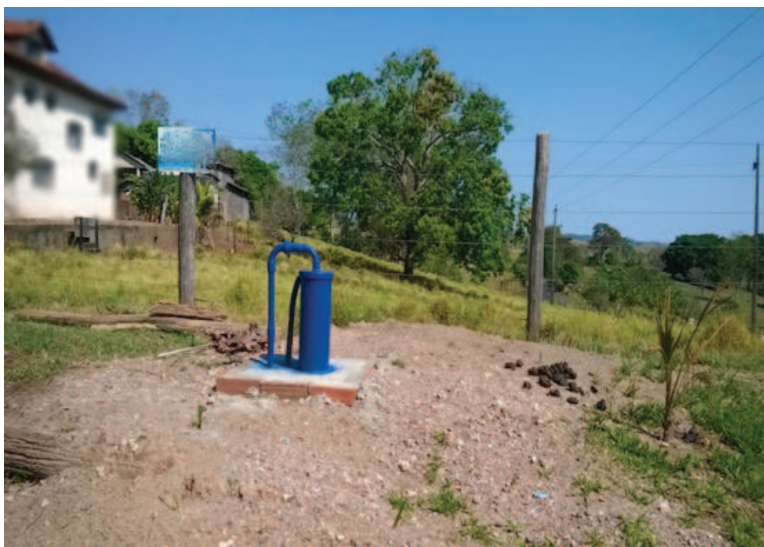
Figura 10. Entorno do poço artesiano da propriedade rural Nº 10, do município de Colorado do Oeste - Rondônia.
