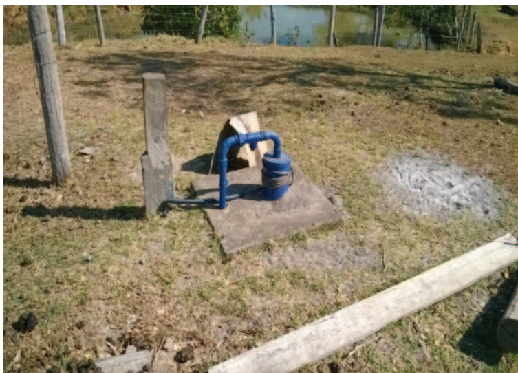
Figura 3. Entorno do poço artesiano da propriedade rural Nº 3, do município de Colorado do Oeste - Rondônia.
