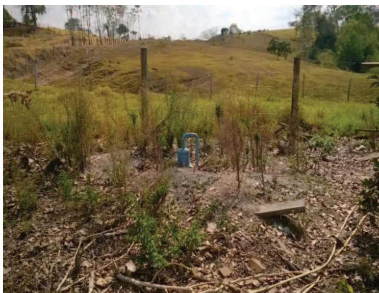
Figura 7. Entorno do poço artesiano da propriedade rural Nº 7, do município de Colorado do Oeste - Rondônia.
