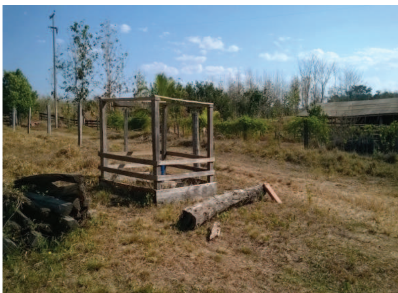
Figura 4. Entorno do poço artesiano da propriedade rural Nº 4, do município de Colorado do Oeste - Rondônia.
