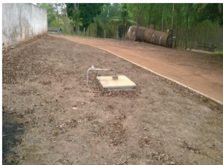
Figura 8. Entorno do poço artesiano da propriedade rural Nº 8, do município de Colorado do Oeste - Rondônia.
